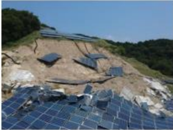
土砂崩れで生じた崩落
